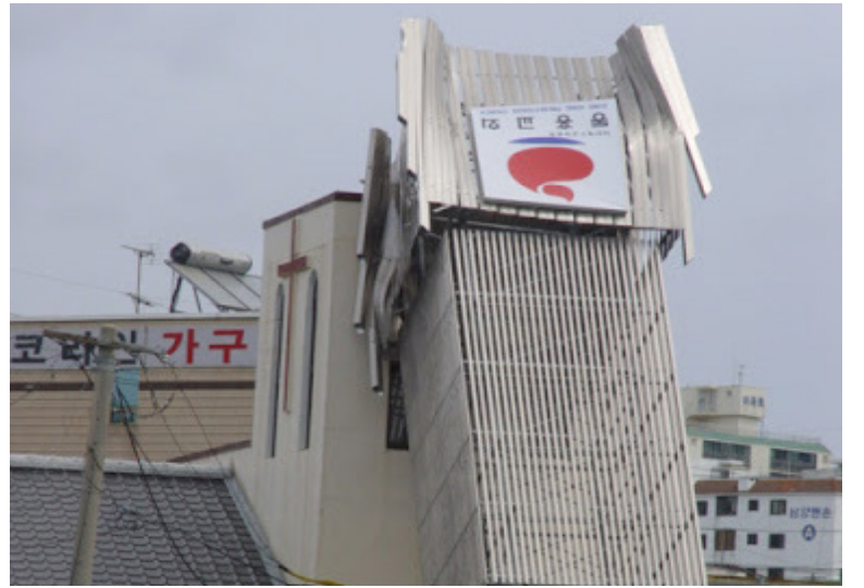
▲최근에 태풍으로 발생한 십자가탑 붕괴사고는 대부분 관리소홀 때문이거나 전문업체가 아닌 무허가 업체가 시공하여 발생한 것으로 사회적으로 많은 문제가 되었고 교회안전에 대한 대안 마련 및 재인식의 소리가 높아졌다. 이로 인해 정부에서는 광고물 및 시설물에 대한 법이 강화됐다.
